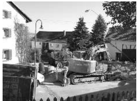
Ende September 2011 begannen die Arbeiten am Ortskanal in der „Alten Schulstraße“
